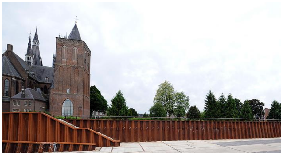
Stalen damwand in zicht houden
