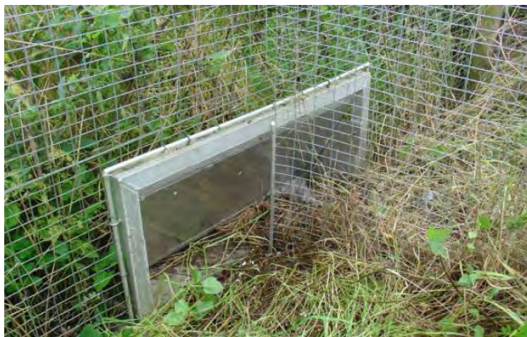
Afbeelding 6.15 Voorbeeld van een uittreedklep voor das
