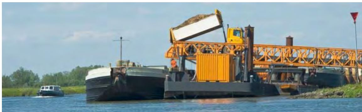
Afbeelding 4.8, voorbeeld van een tijdelijke laad- en loswal
