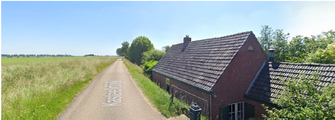
Afbeelding 3.6 Huidige dijkwoning aan de kasteeldijk tussen Macharen en Oijen
