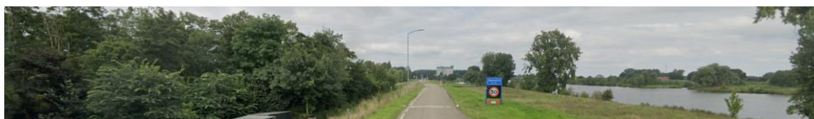
Moderne gronddijk van A50 tot Ravenstein.
